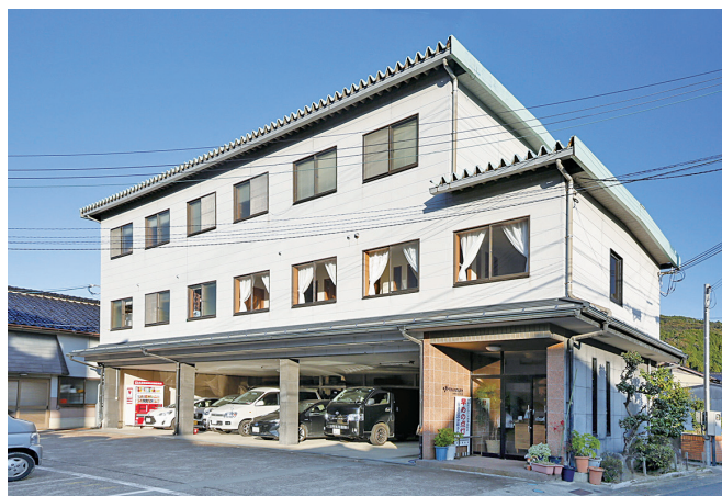
「ひと」と「もの」との建設業
